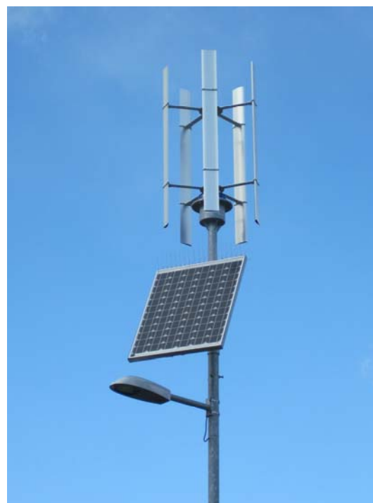
Obr. 4 Vertikální Darrieova malá větrná elektrárna (200 Wp) v kombinaci s fotovoltaickým panelem (130 Wp) a výbojkovým svítidlem o příkonu 51 W.
