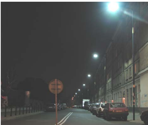
Rys. 2. Widok ul. Dzielnej oświetlonej oprawami typu LED (sześć kolejnych opraw)
