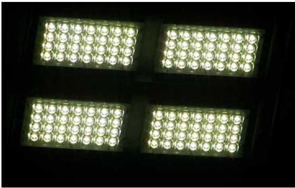
Rys. 1. Widok modułów świecących opraw z diodami elektro-luminescencyjnymi
