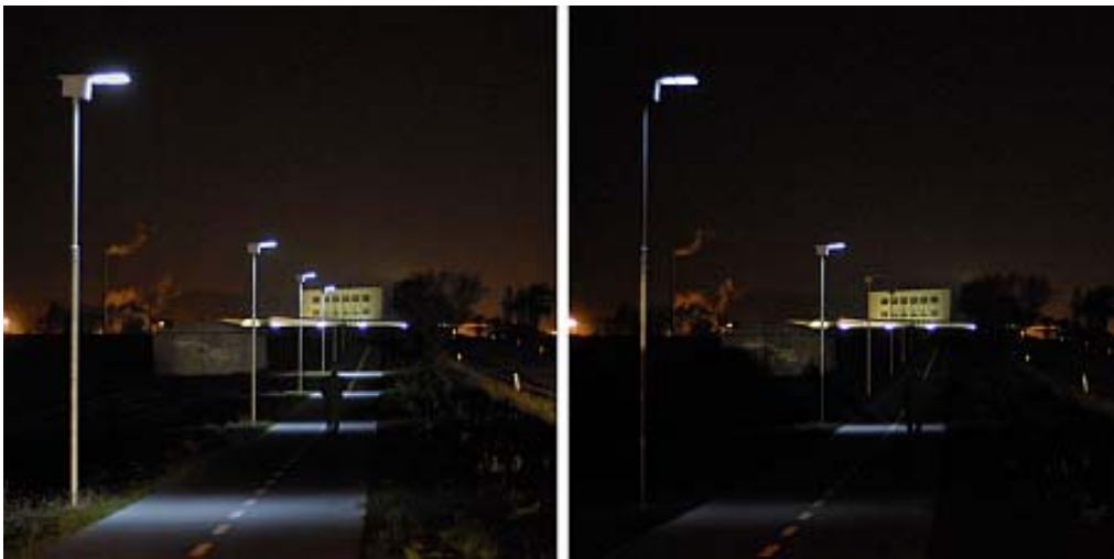
Obr. 6 – Také „realizace“ s LED svítidly. Nebezpečná i pro cyklisty, jimž je určena. Měsíc zajistí mnohem intenzivnější a kvalitnější osvětlení. A to zdaleka nemusí být v úplňku. Soustava byla napájena fotovoltaickými panely. S nástupem podzimu a zatažených dní nebyly sto zajistit dostatečné množství energie – svítidla reagovala tak, že se pokoušela o zapnutí, ovšem vzápětí se vypínala. Jak je patrné z porovnání obrázků. V současnosti je cyklostezka osvětlena klasickými svítidly.
